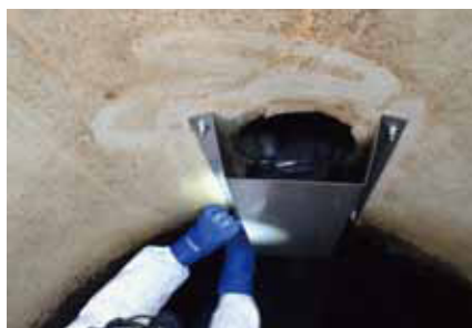
①既設のバッフル板を撤去。
