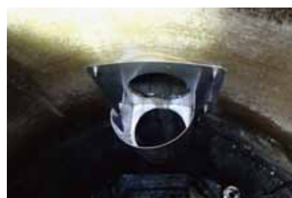
⑤汚水受けの取付。 ※製品の形状が最新型と異なります
